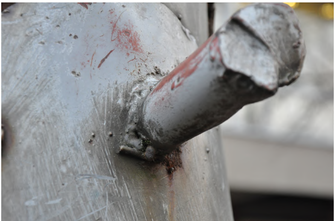
Detalj skulpture Govornik. Na mjestima oštećenja vidi se sloj crvenog temeljnog premaza. Na temeljnu je boju nanesen sloj srebrno-sive boje i, iznad njega, zaštitni premaz.(?) (Foto: S. M. Sunara, 11. prosinca 2015.)
