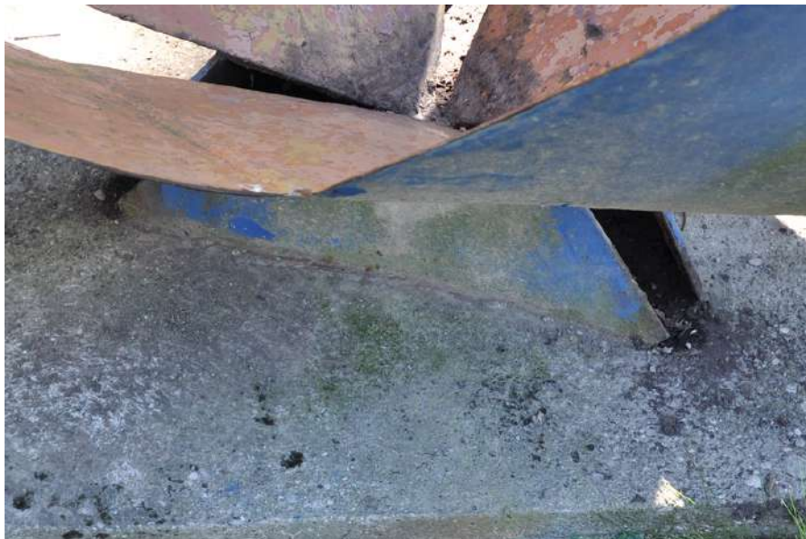
Slika 67. Rubni dijelovi elemenata koji tvore bazu zahvaćeni su korozijom (foto: S. M. Sunara, rujan 2017.)
