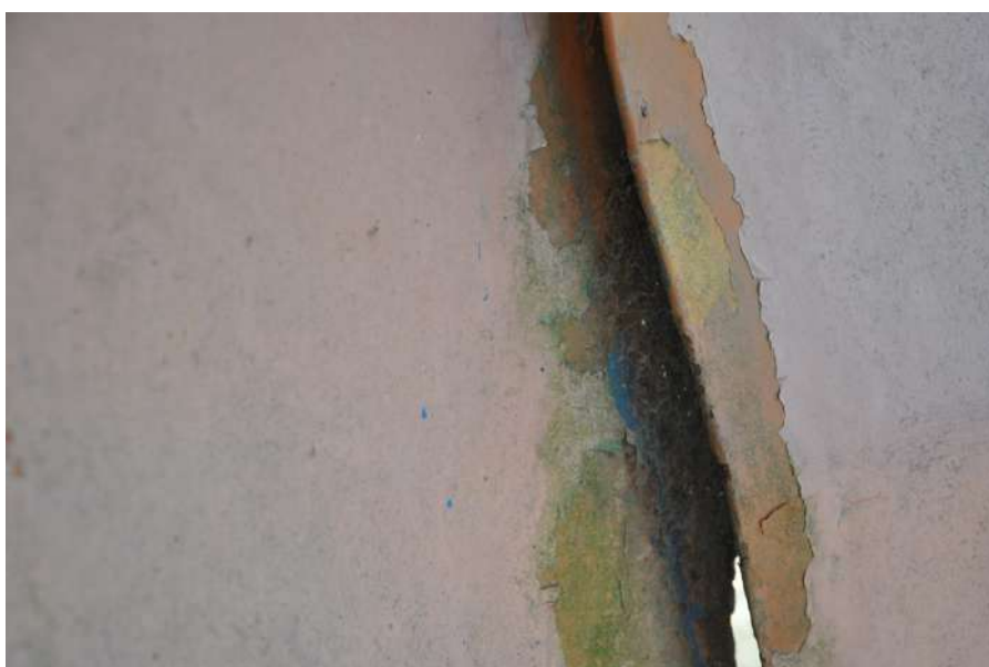
Slika 23. Tragovi plave boje u unutrašnjosti skulpture (foto: S. M. Sunara, rujan 2017.)
