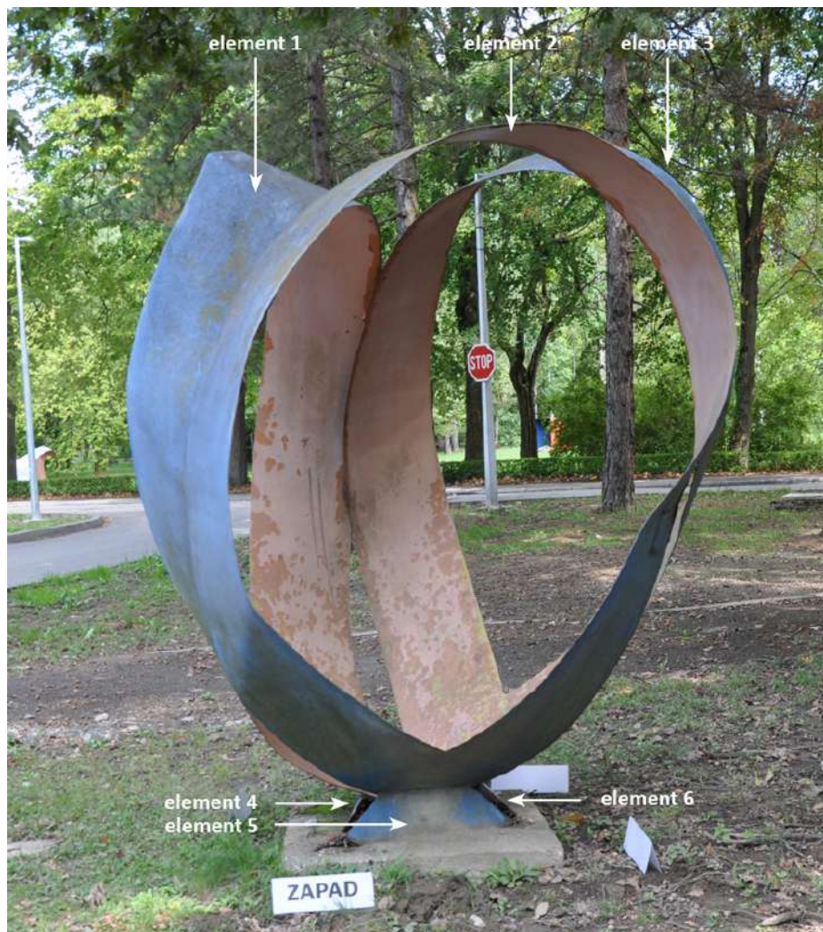
Slika 13. Fotografija na kojoj su označene latice i tri elementa koja tvore bazu skulpture (foto: S. M. Sunara, rujan 2017.). Ojačanja koja se nalaze u unutrašnjosti baze (ispod donjeg dijela latica) nisu označena, jer se na slici ne vide
