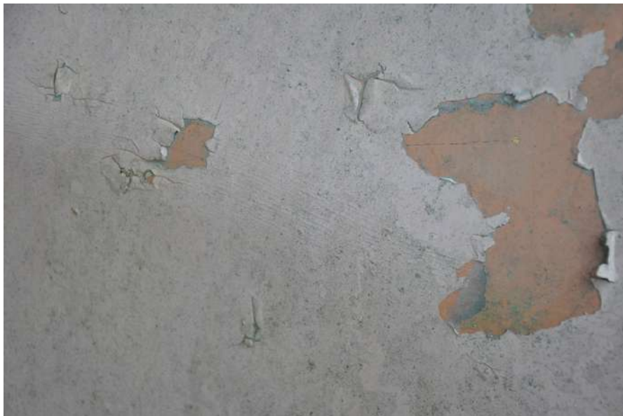
Slika 71. Iskrakelirani premazni slojevi na mjestu deformacije čelične trake – unutrašnja strana elementa 2 (foto: S. M. Sunara, rujan 2017.)
