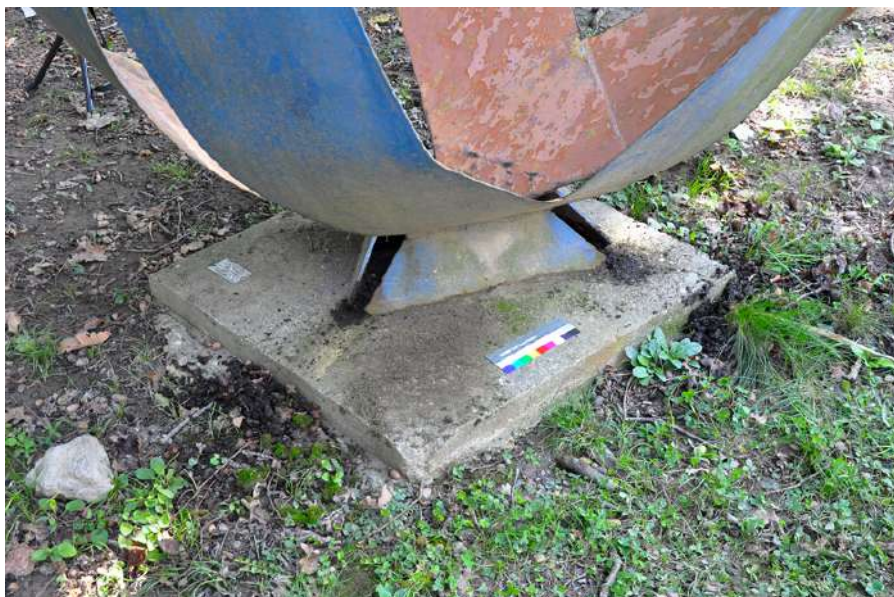
Slika 47. Metalna baza skulpture ugrađena je u betonski podest; drugi načini pričvršćivanja nisu vidljivi (foto: S. M. Sunara, rujan 2017.)
