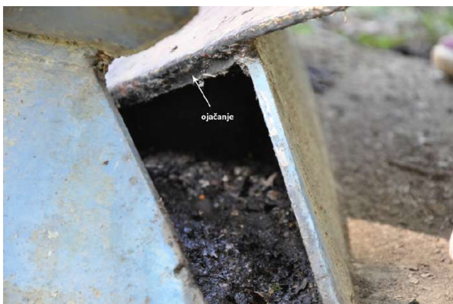
Slika 17. Ojačanje u donjem dijelu laticе (foto: S. M. Sunara, rujan 2017.).
